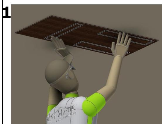
A l'aide du gabarit, tracer l'emplacement du climatiseur (attention à ce que rien n'empêche l'accès à la trappe du filtre)
